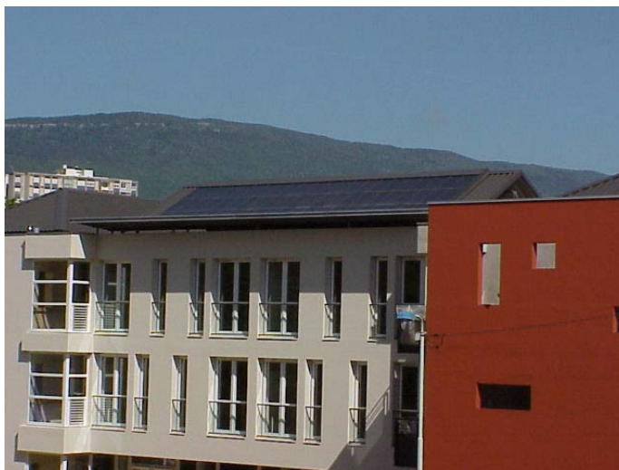
Figure 85 : Façade sud des Berges de l'Hyères
